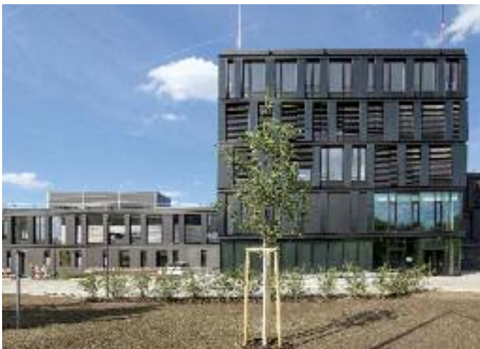
Gebäudeintegrierte Photovoltaik: CIGS-Dünnschichtmodule an der Fassade des ZSW-Institutsgebäudes in Stuttgart.
