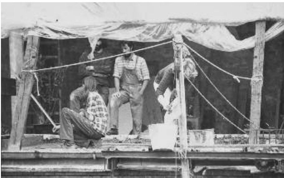
Ebenfalls 1981 wurde die ersten Dachterrassen gebaut.
