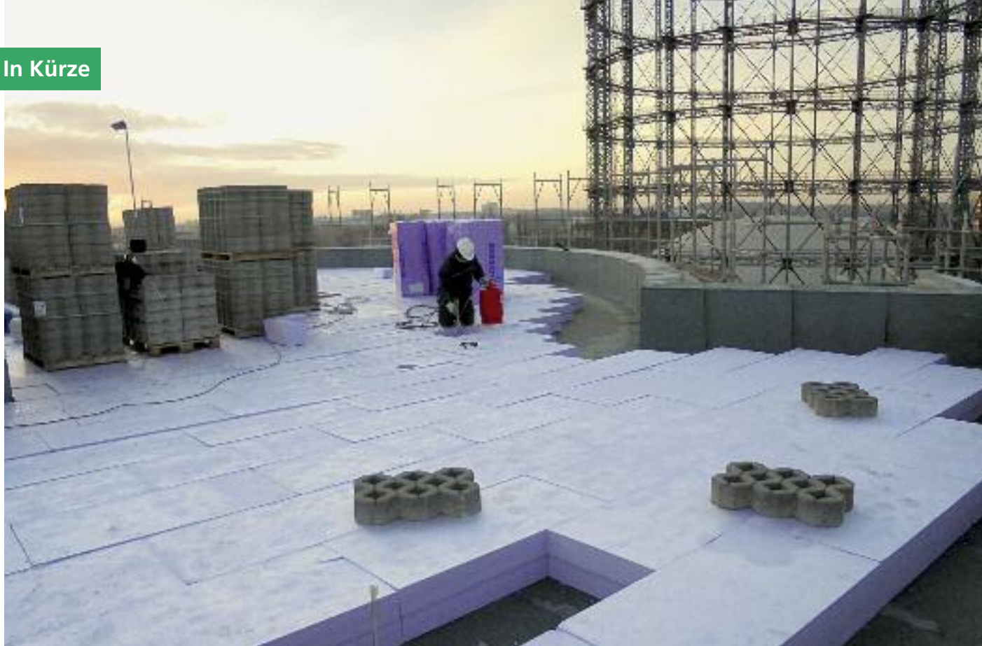
Das Bürogebäude auf dem Campus 14 des Europäischen Energieforums (EUREF) in Berlin erhielt von Jackon Insulation eine Begrünung.
