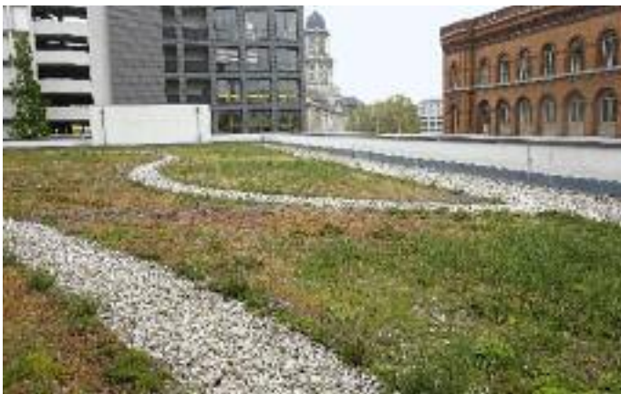
Rathauspassagen: extensive Dachbegrünung östlich vom Roten Rathaus.
