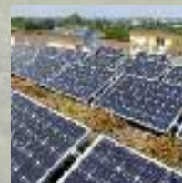
Photovoltaik mit Dachbegrünung
