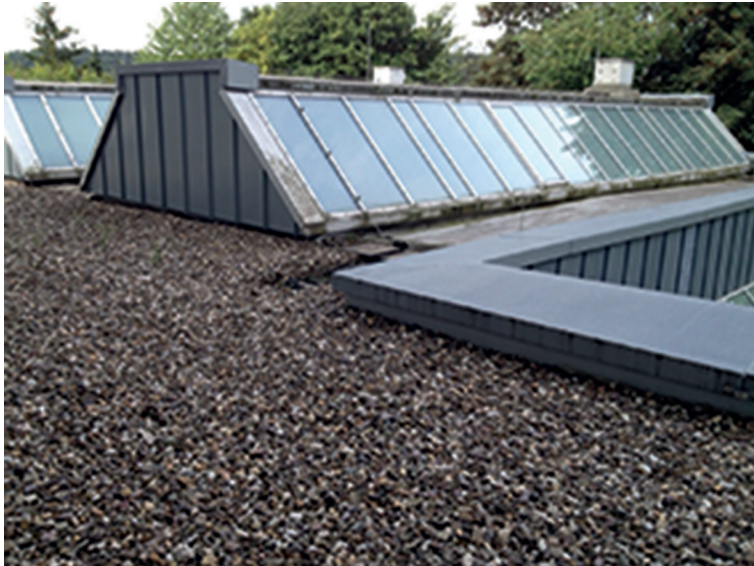
Bild 24: Kiesschicht auf einem nicht genutzten Dach als schwerer Oberflächenschutz (Quelle: Schmidt)
